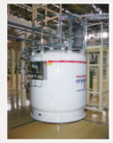
3000L 液化ヘリウム貯槽
