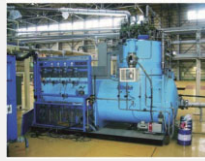
TCF200 ヘリウム液化冷凍機
